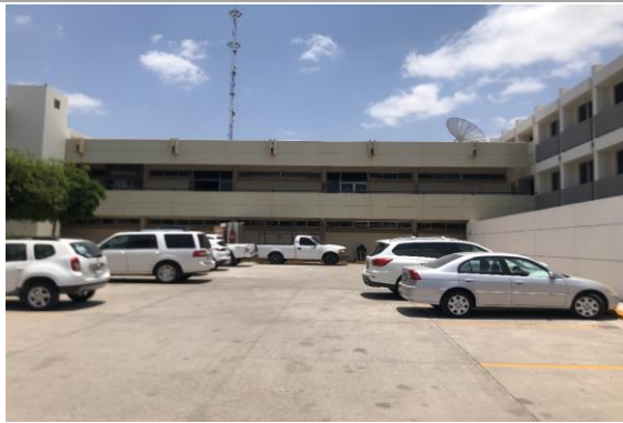
F1: Fachada principal
