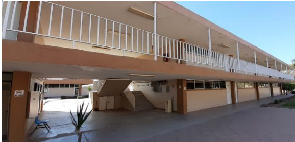
F1: Fachada principal
