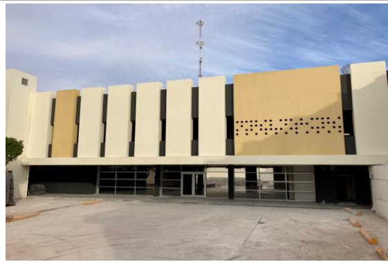
F1: Fachada principal
