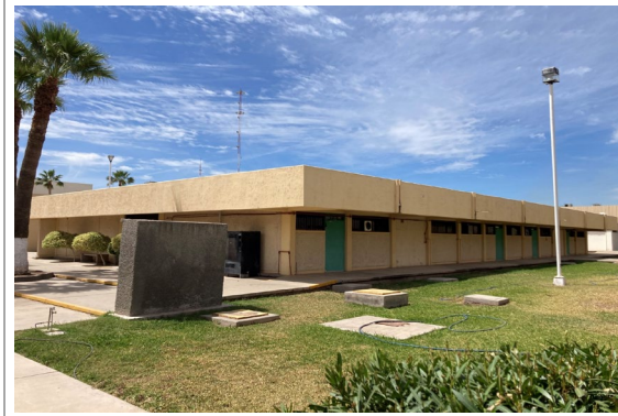
F2: Fachada Posterior
