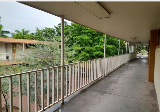
F3: Pasillo Planta Alta
