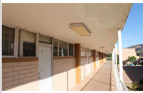
F3: Pasillo Planta Alta
