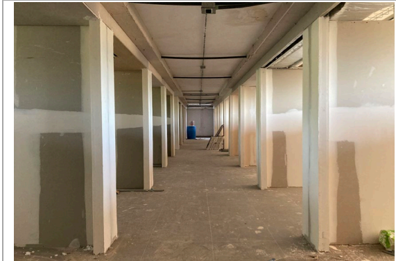
F5: Interior Cubículos
