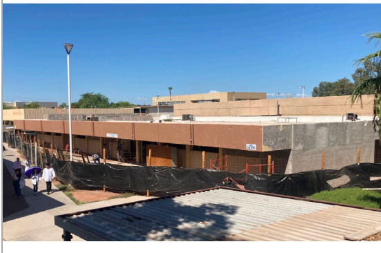
F1: Fachada principal
