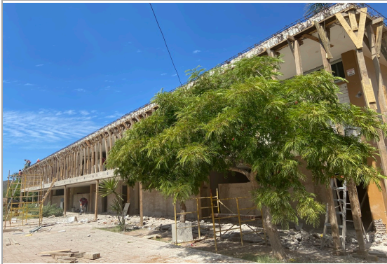
F1: Fachada principal
