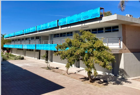
F1: Fachada principal
