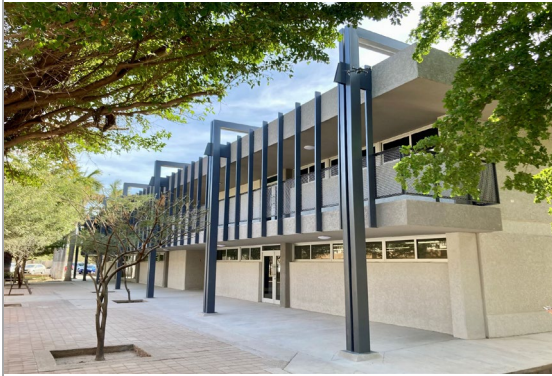
F1: Fachada principal
