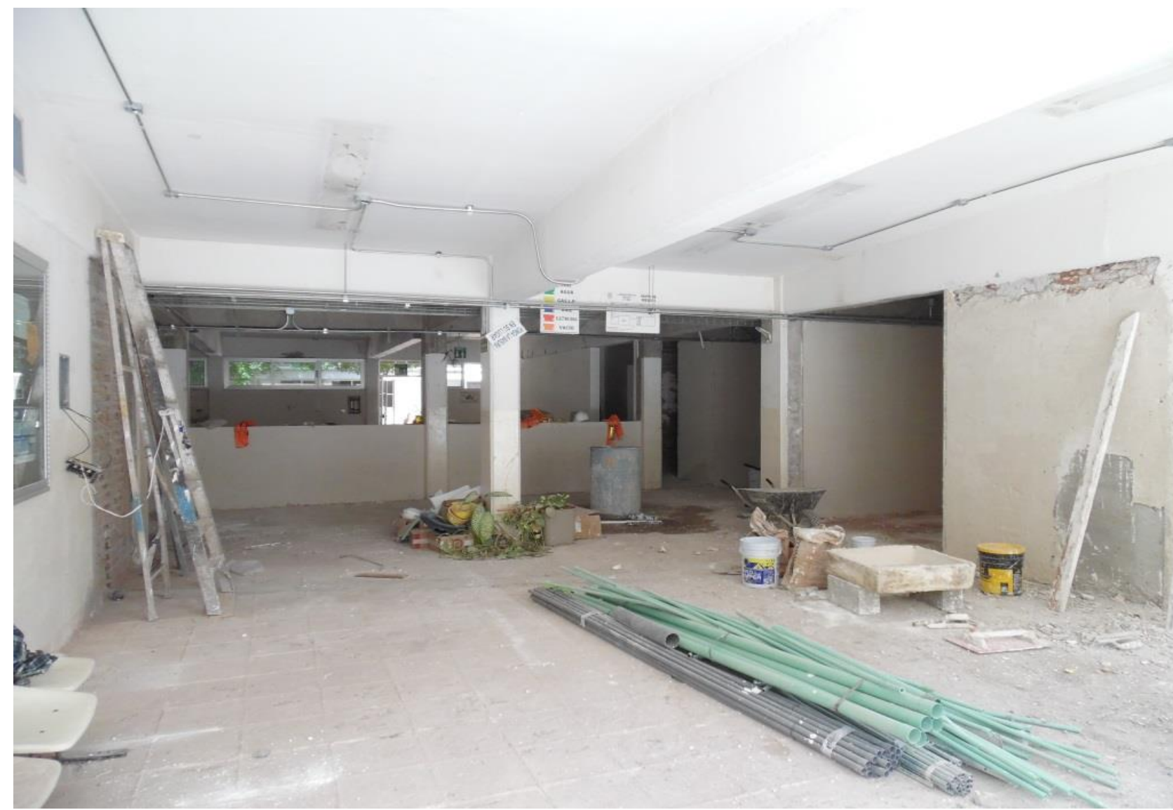
F2: Acceso / Lobby
