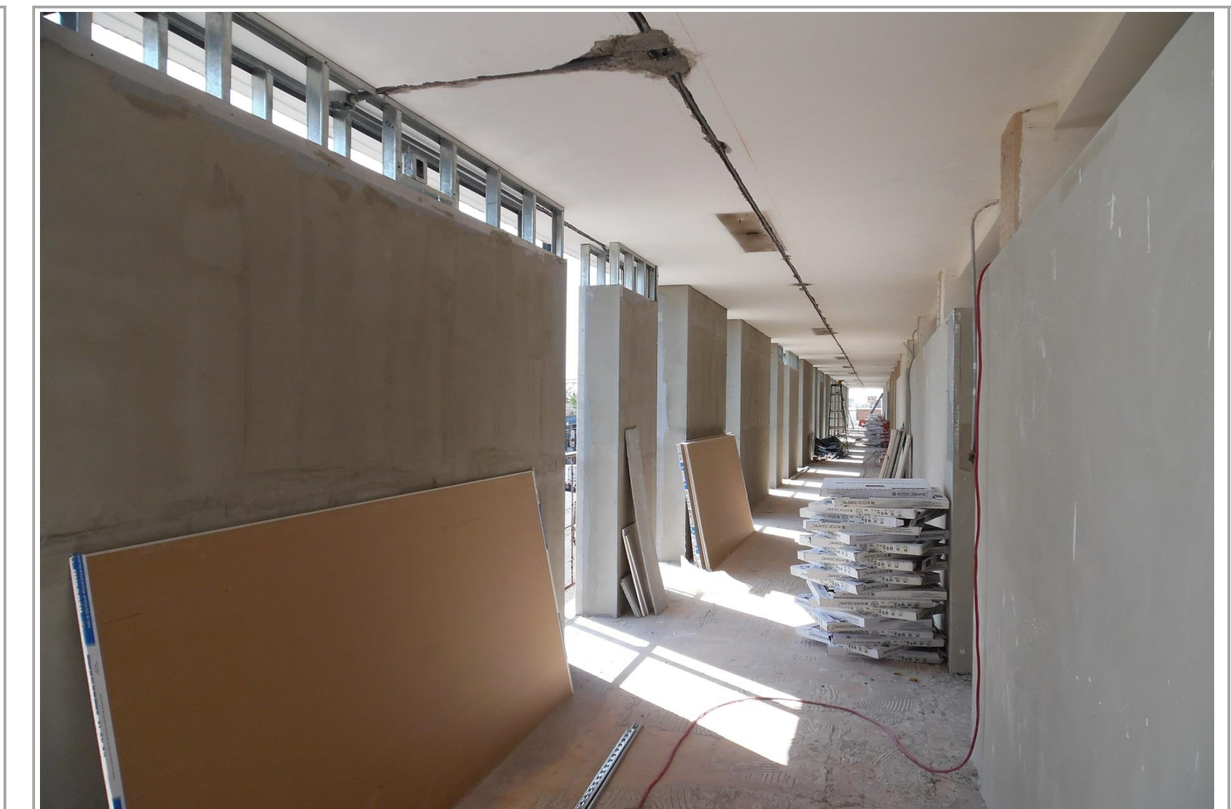
F5: Pasillo Tercer Nivel
