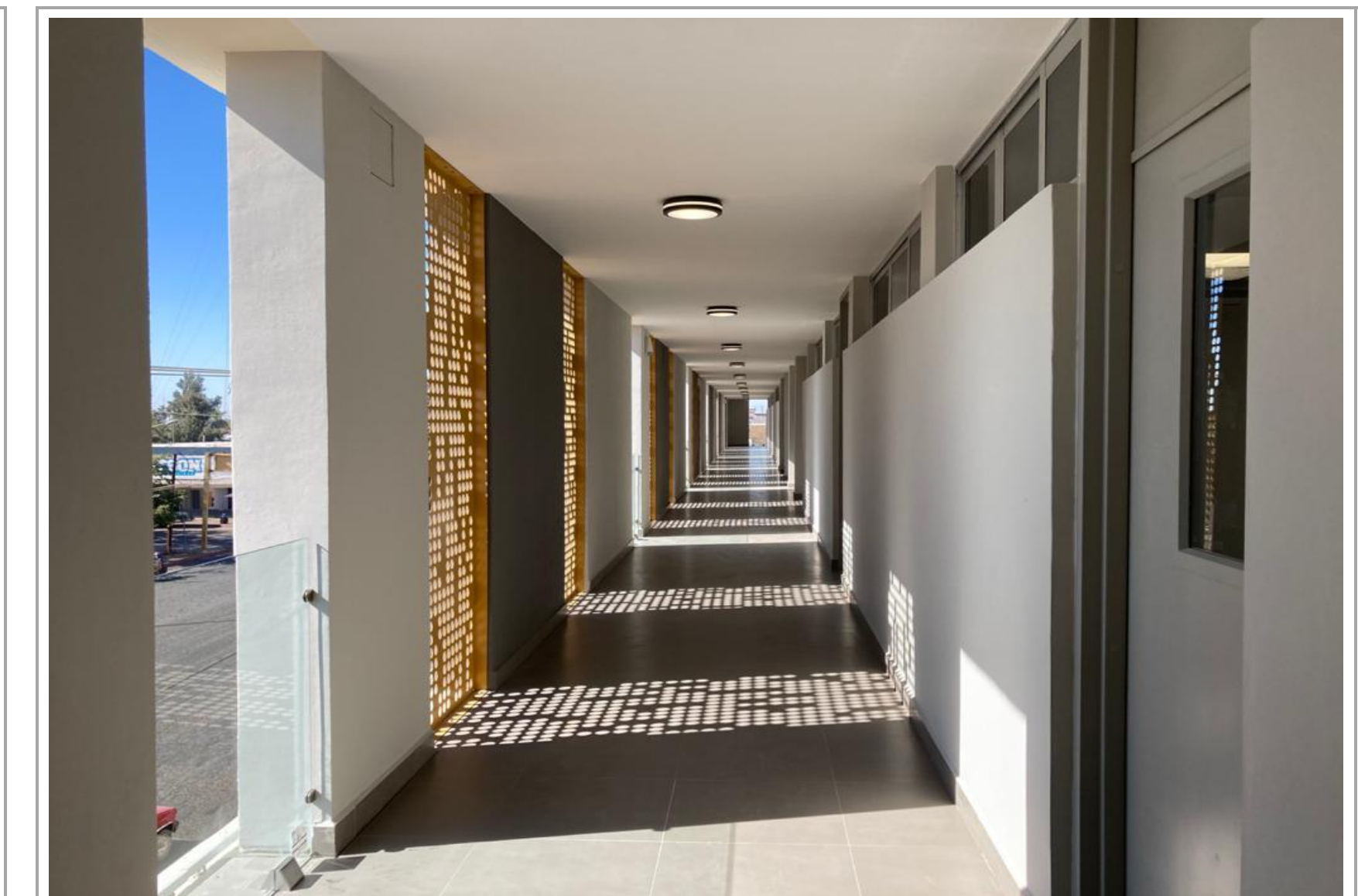
F5: Pasillo Tercer Nivel
