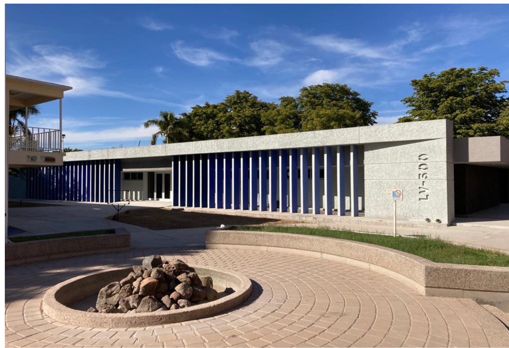
F1: Fachada principal
