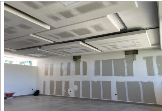
F4: Interior / Pasillo Sur
