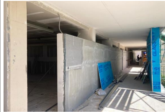
F2: Pasillo Segundo Nivel
