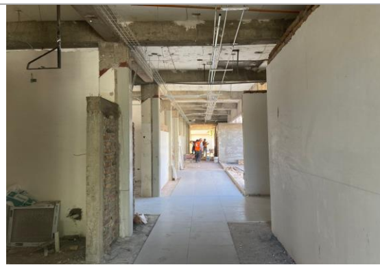
F4: Pasillo de acceso a Laboratorios Sur
