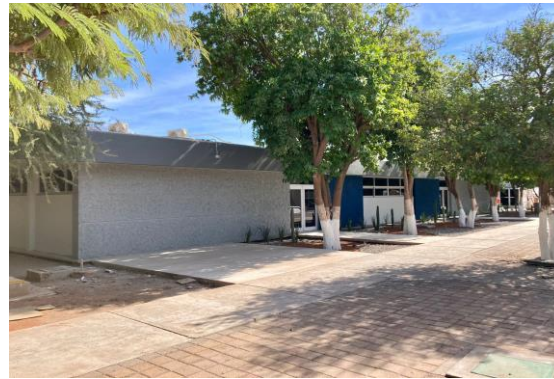
F2: Fachada posterior
