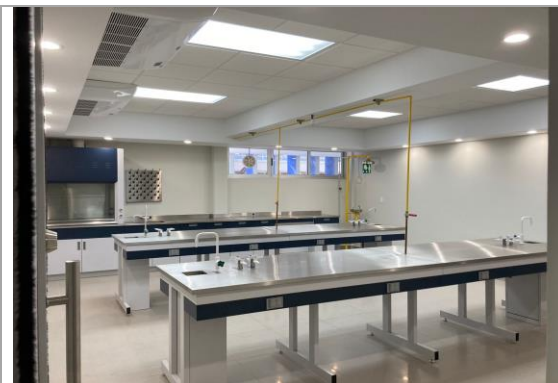
F4: Pasillo de acceso a salas
